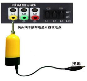
提示:由于带电显示器的主要作用是显示开关柜是否带电,并非标准的核相点,且不同厂家、不同时期、不同标准的带电显示器会产生不同程度的移相问题,且带电显示器 L1、L2、L3 与母线的对应关系不一定正确,若核相结果异常则应在一次线路上进行核相。
